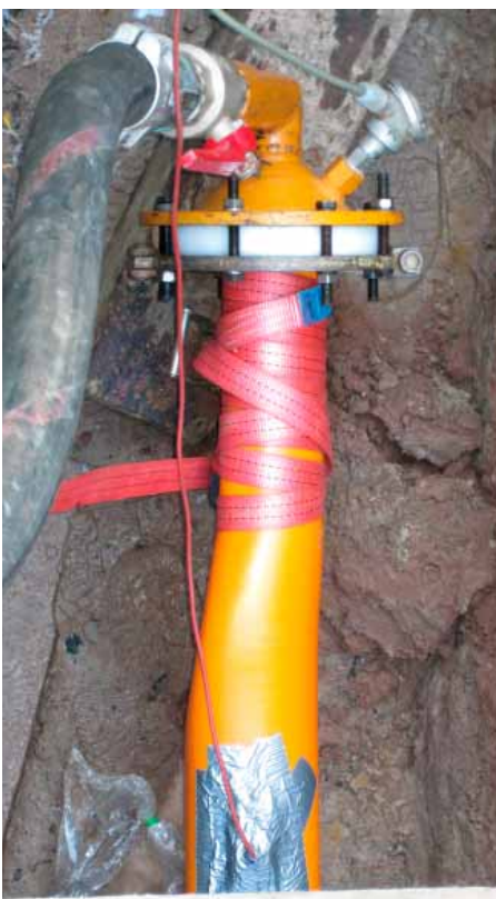
Dampfanschluss mit Temperaturkompensation.
