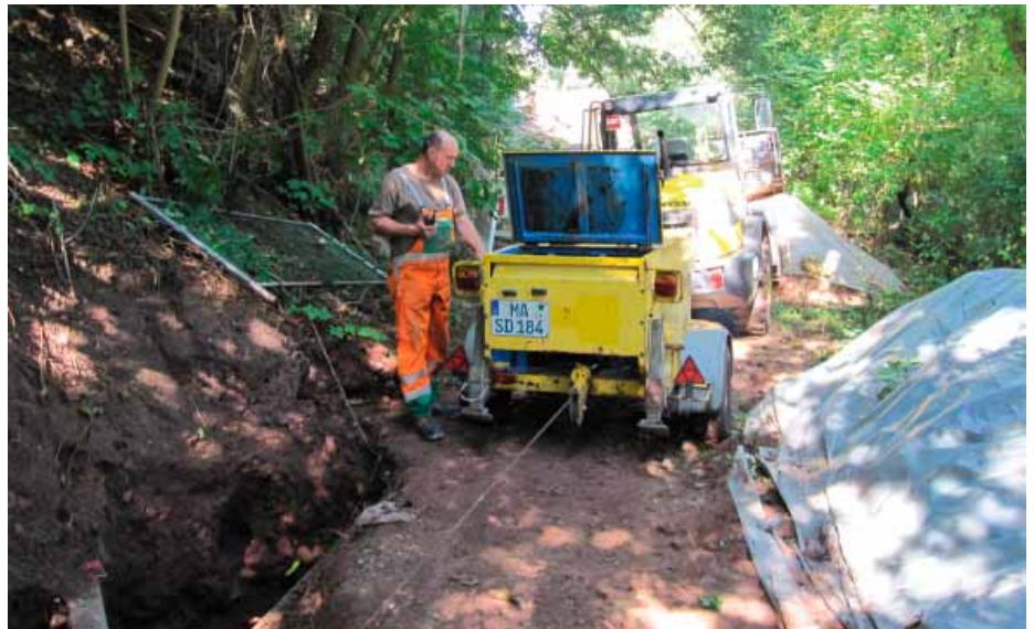
Rohreinzug mit einer 5 to. Winde.
