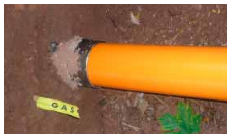
Rohrstrang nach der Bedampfung.
