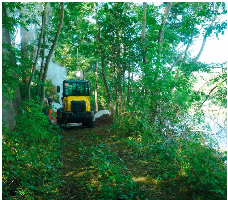
Eindruck von der Trasse während der Bedampfung.
