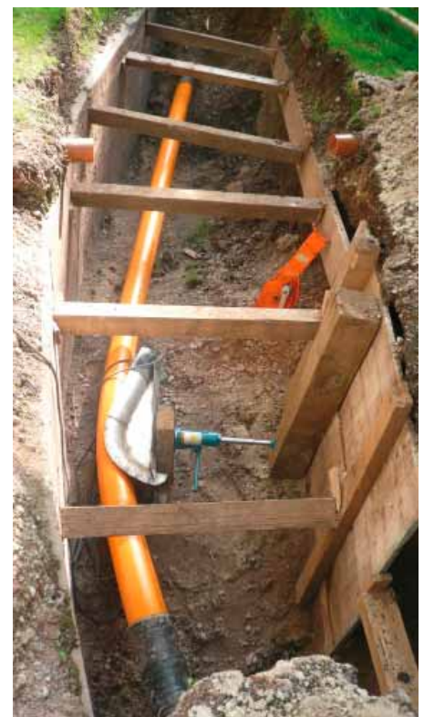
Um einen optimalen Bogen in der freien Strecke zu herzustellen, wurden entsprechende Hilfsmittel eingesetzt.
