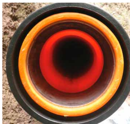
Fertiges Compact Pipe Rohr nach der Bedampfung mit Stützhülse und Relining-Muffe der Fa. Friatec.
