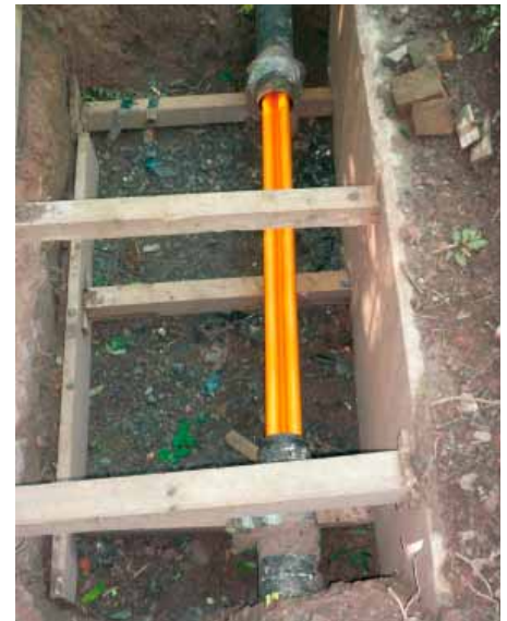
Rohrstrang vor der Bedampfung. Die Baugrube wurde für die Kamerabefahrung geöffnet.
