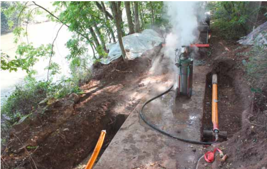
Dampfauslass am ersten Wechsel. Gut zu erkennen der rechteckige Regenwassersammler aus Ort beton.
