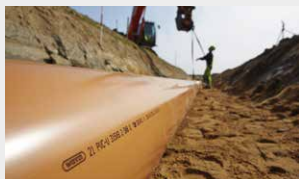
Afløbsrør - til transport af spildevand
